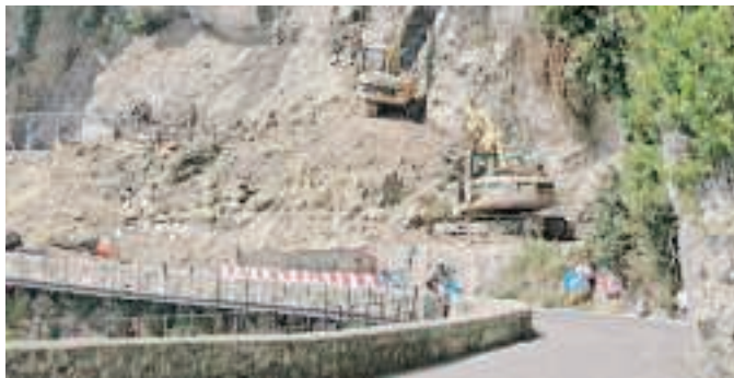
Il cantiere per la realizzazione di box a Paraggi
